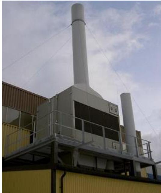
Figura 9.4: Recuperador de calor gas-gas de flujo cruzado
